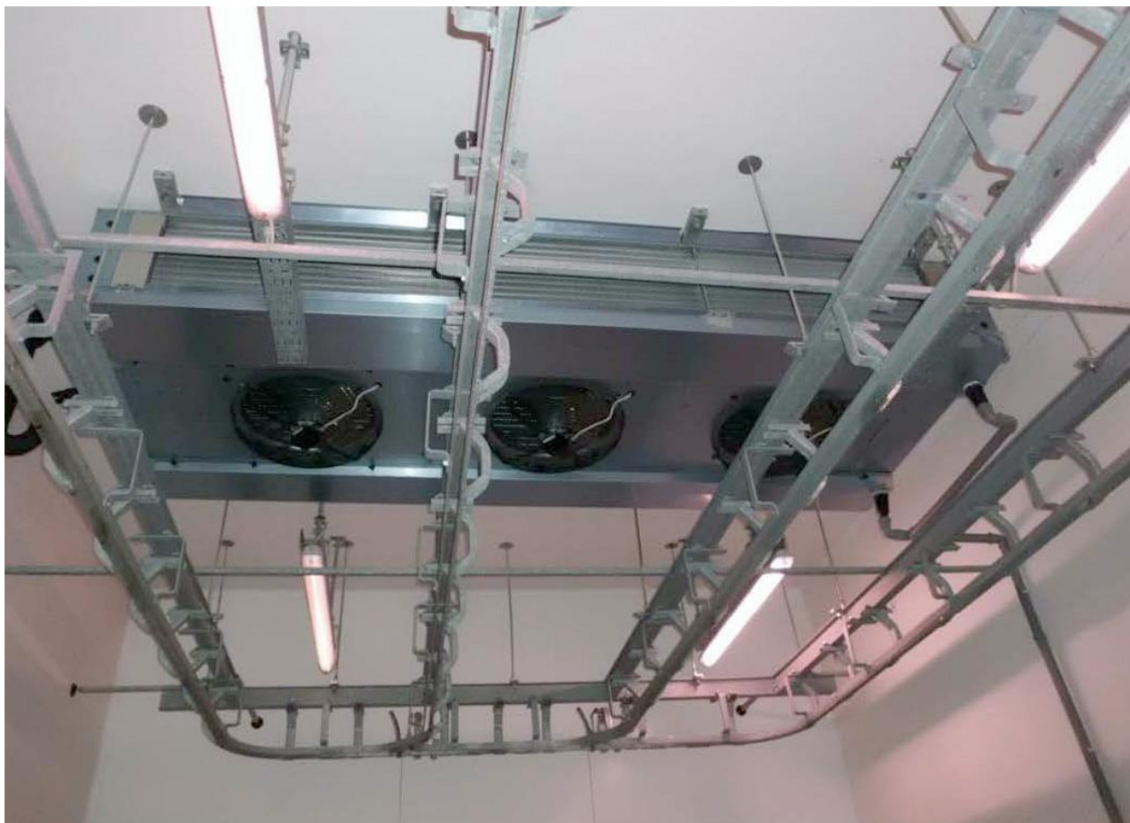
IDE – niskie zawieszenie dla instalacji technicznych
